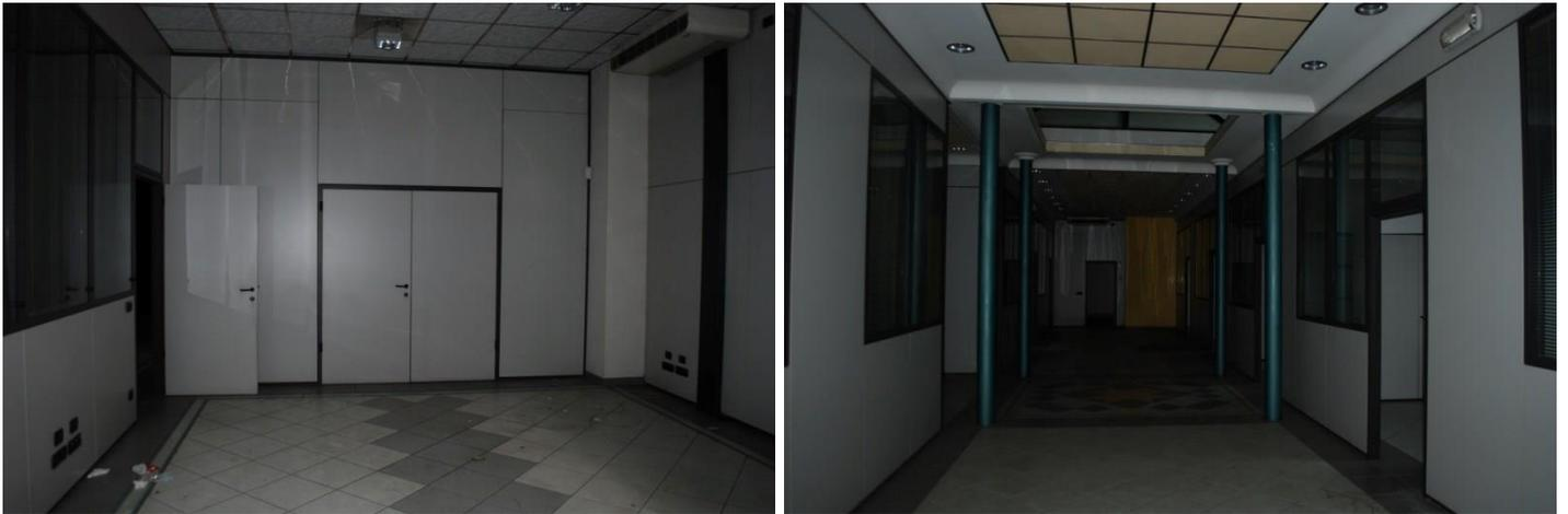
La porzione di uffici al piano rialzato, che si trova nel corpo di fabbrica non industriale (al di sotto dell'abitazione), presenta caratteristiche di finiture risalenti all'epoca di costruzione e cioè anni '80, con pavimentazioni in ceramica, pareti intonacate a civile e tinteggiate, serramenti alle finestre in alluminio anodizzato e vetrocamera, porte interne in legno con o senza specchiatura a vetro, inferriate metalliche alle finestre.
